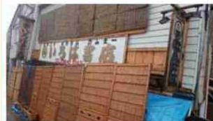
被災した旧店舗の外観
