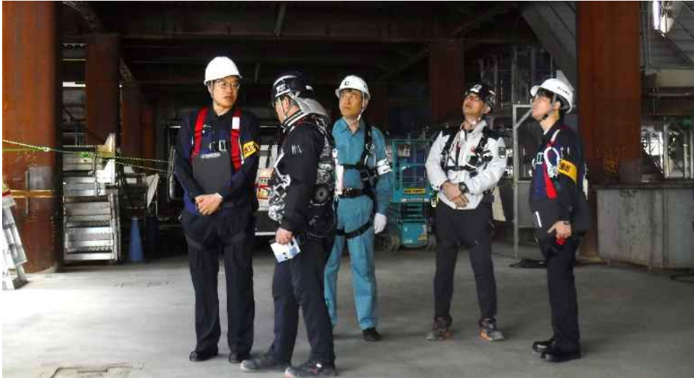
浦和駅西口高砂地区第一種市街地再開発事業に伴う施設建築物新築工事 (施工者：前田・斎藤・タカラ共同企業体)
