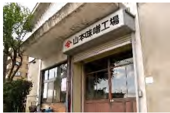
味噌を醸造する工場の外観
