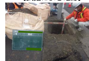
【試掘による確認】
