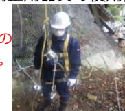
【墜落制止用器具の使用】
