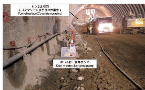
トンネル掘削現場における粉じん測定 Measurements of the dust concentration at a tunnel construction site.
