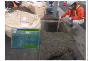
【試掘による確認】
