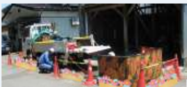
<新潟> 工事エリア付近の植樹
