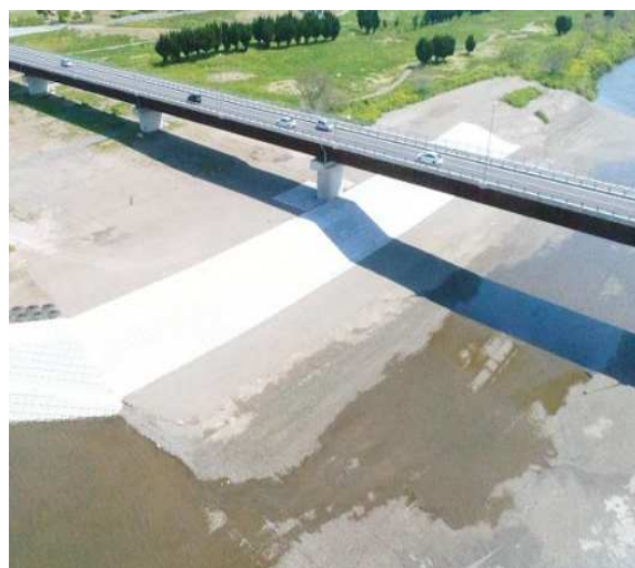
施工実績（上武大橋左岸低水護岸工事）
