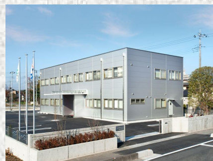
（株）高橋土建本社（2010年完成）
