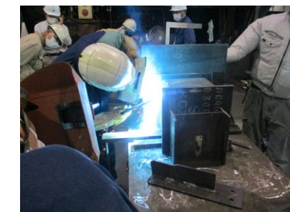
溶接作業（工場内）
