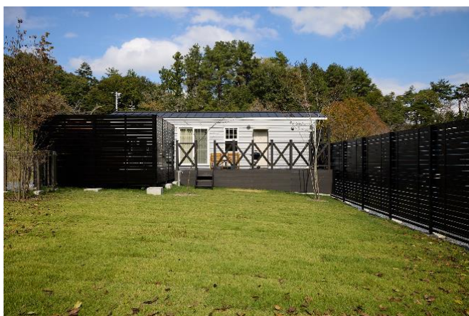
●トレーラーハウスエリア
