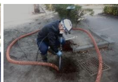
↑下水道の修繕・維持
