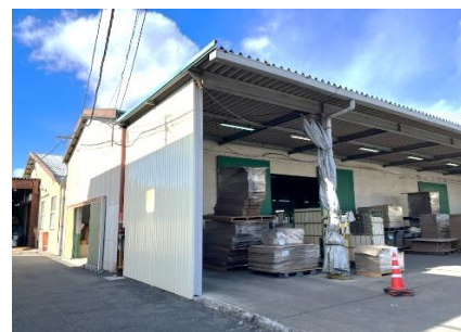
第二工場外観
