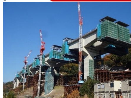
高速道路工事用架設機械です。
