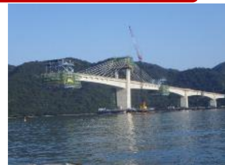
橋梁工事用架設機械です。
