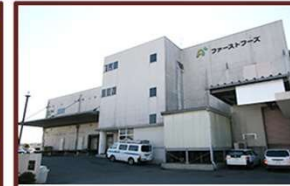
武蔵工場外観
