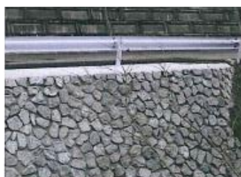
河川の護岸を補強する工
