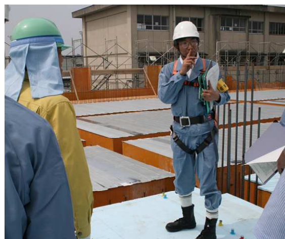
2階スラブ型枠組立現場でのパトロール状況
