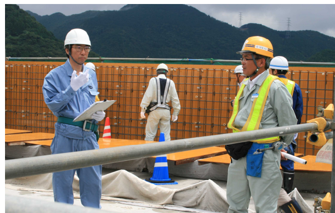
型枠組立現場でのパトロール状況
