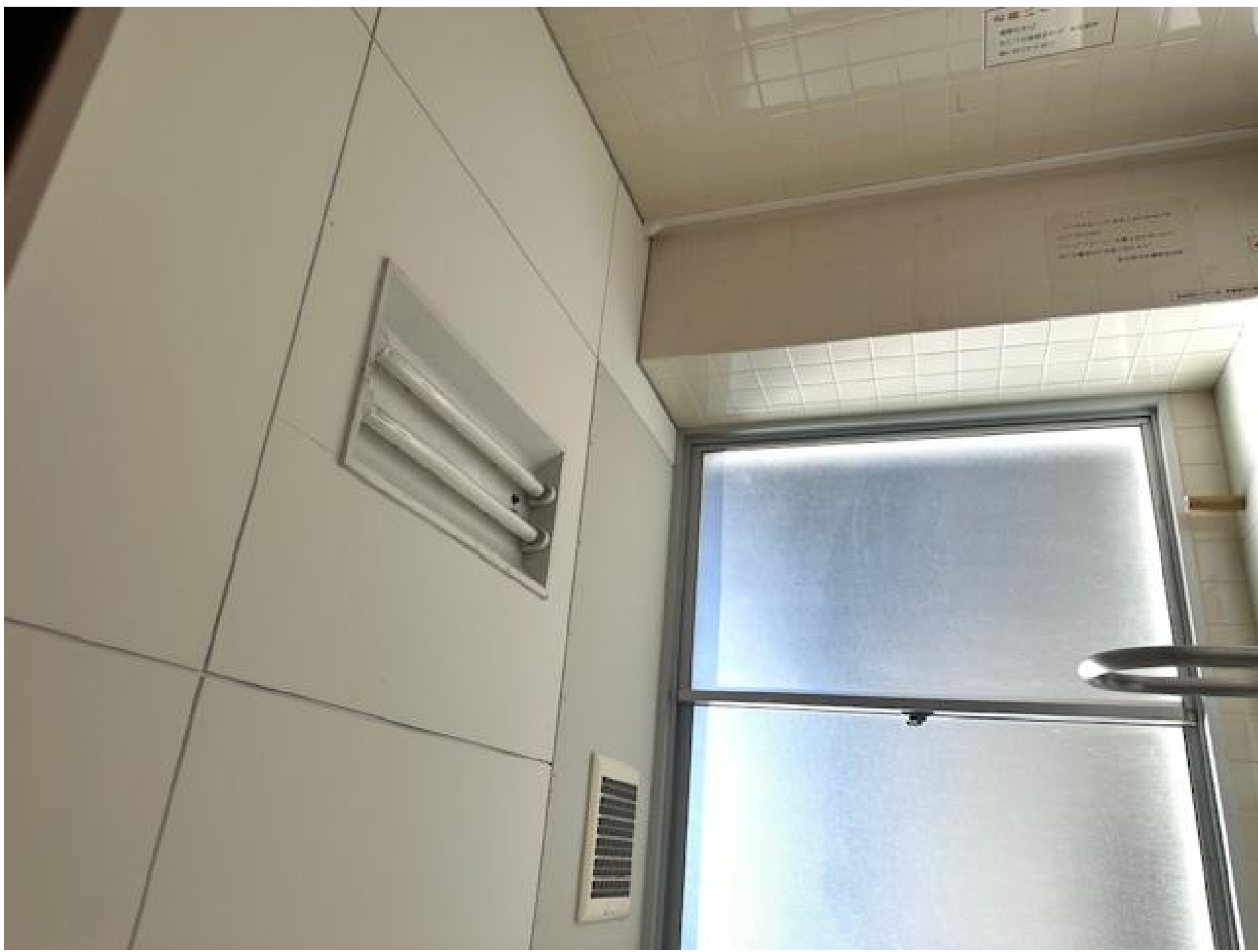
①1階障害者用トイレ
