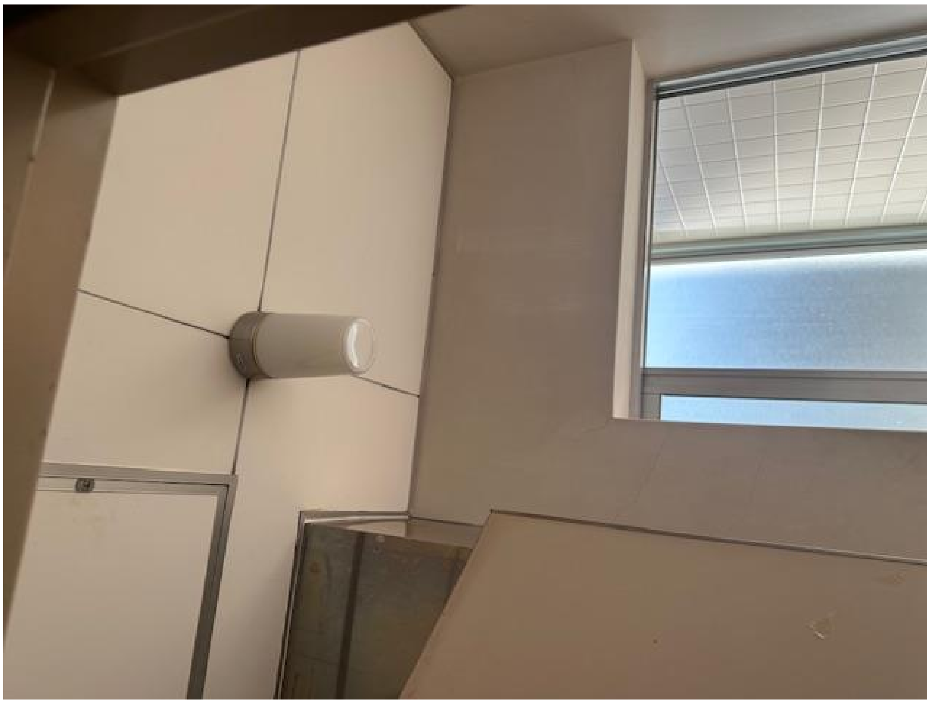
①2階元シャワー室脱衣所
