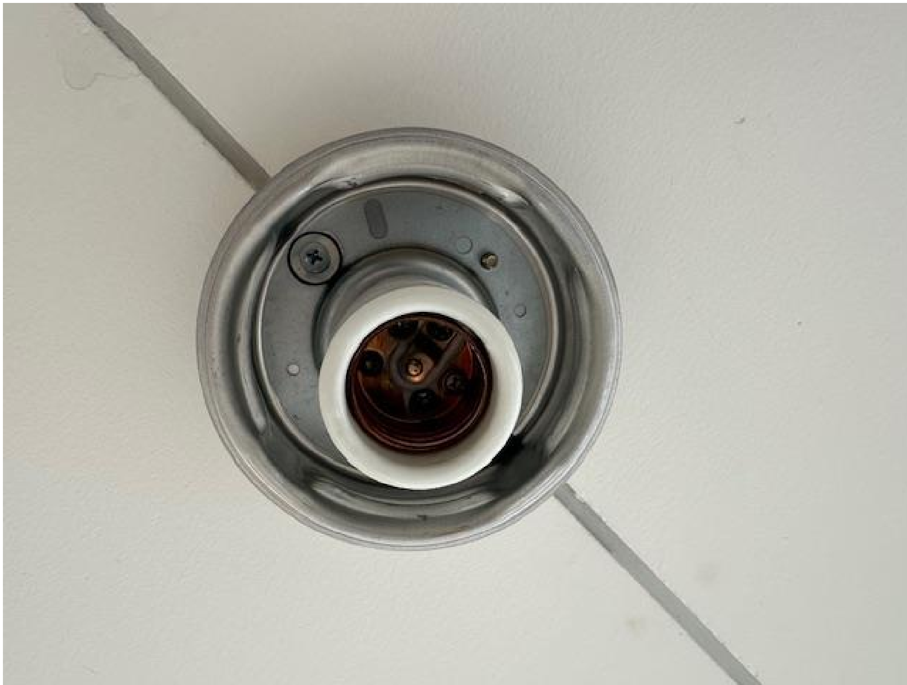
①1階職員用通路&2階シャワー室&脱衣所 接続部
