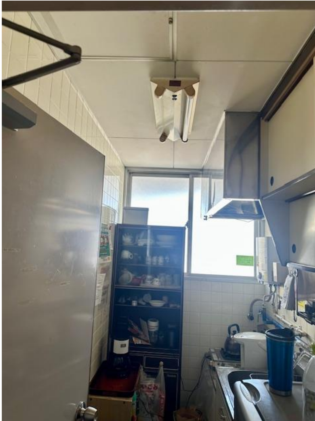
④1階給湯室
