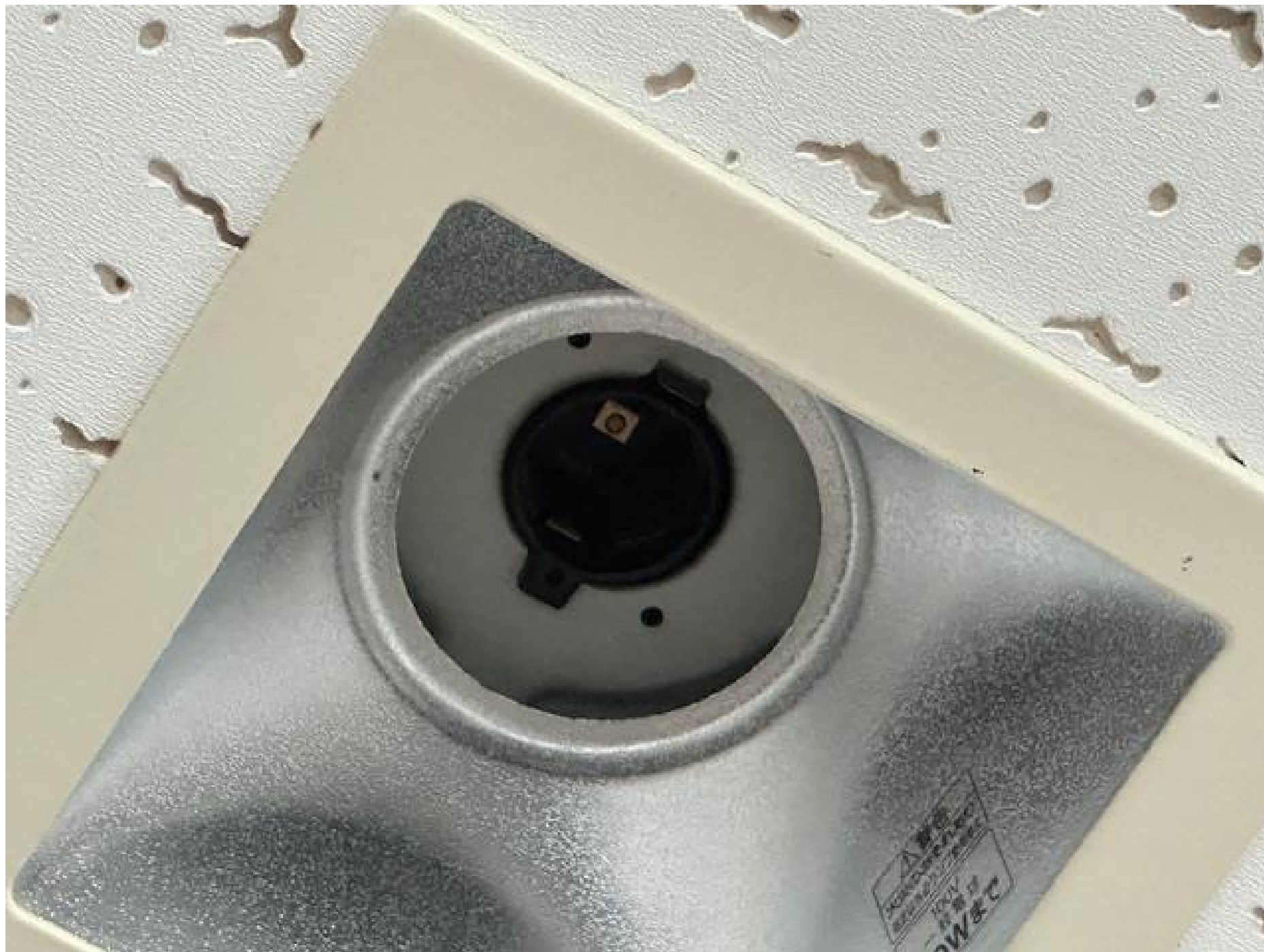
⑤2階多目的室接続部
