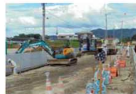
道路築造工事の土工作業風景
