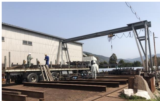
制作された何トンもある材料が搬送され、トラックへ積み込まれます。
