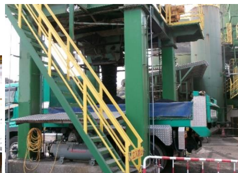
トラックが到着するとアスファルト合材が積み込まれます。
