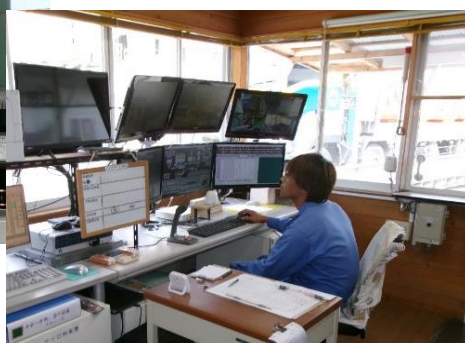
オペレーター室
