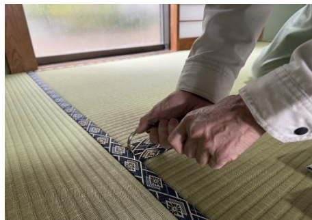
完成畳の納品 (現場のサイズにピッタリ施工！)
