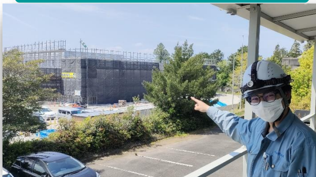
西部学校給食センターも現場の一つ
