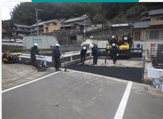
舗装工事の様子
