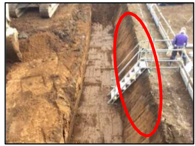
オープンカット法面整形(60° 3D)
