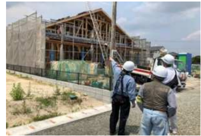
【現場安全パトロール】
