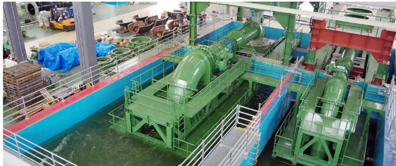
▲ 第1ポンプ試験水槽
