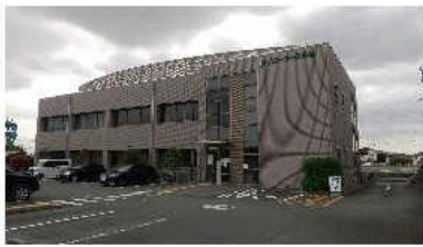
1 外観(裏側:JR線側から撮影、駐車場有り)
