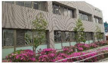
2 外観(表側:4月はつつじが咲いています)
