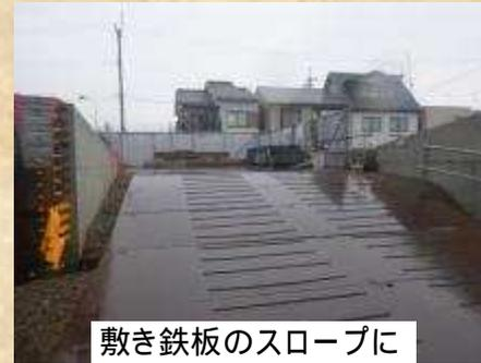
敷き鉄板のスロープに滑り止めの鉄筋を溶接
