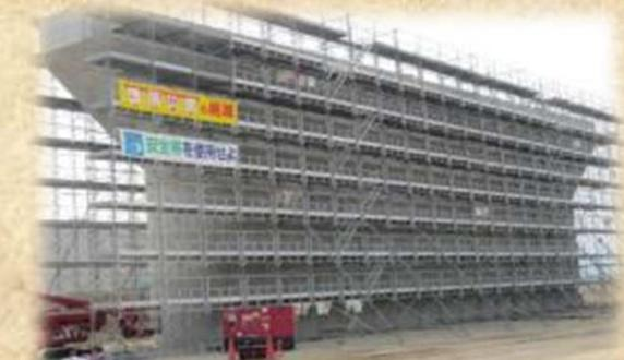
足場通路およびブラケット足場上の整理整頓、段差解除に心がけ、転倒、躓き防止および落下物による災害防止措置としている。
