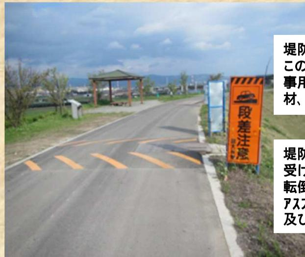
堤防道路を工事用道路として使用している。この道路には光ケーブルのマンホールがあり、工事用車両の重量に耐えられないことから鋼材、アスファルトで防護をしている。
