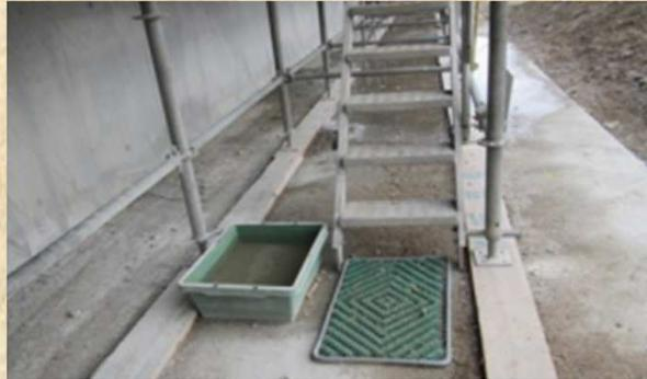
ビーター足場の登り口に靴洗い場を設け、靴裏のドロによる滑りを防止している
