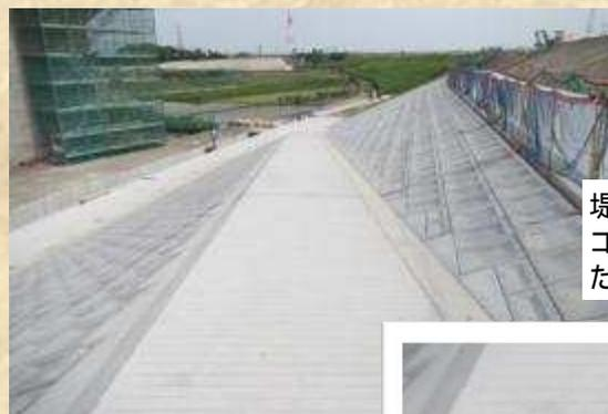
堤防の通行斜路に滑り止めとして、コンクリートカッターにて溝を設置した。
