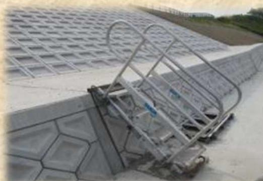
護岸工として堤防に張ブロックを設置しているが、わずかな段差においても飛び降りやよじ登りをしないよう昇降設備を設置している。
