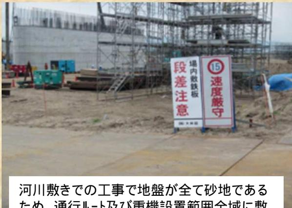
河川敷きでの工事で地盤が全て砂地であるため、通行ルート及び重機設置範囲全域に敷鉄板を設置している。
