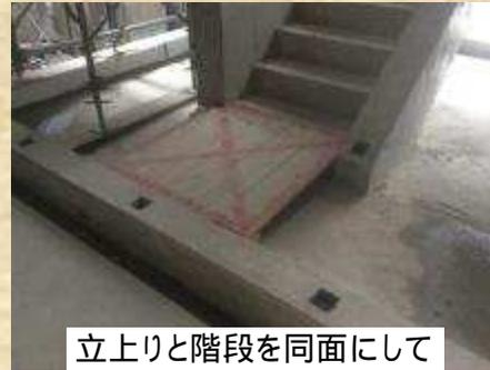
立上りと階段を同面にして余計な段差解消
