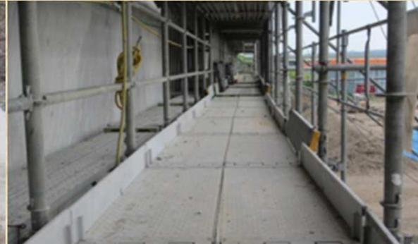
足場通路の整理整頓、段差解除に心がけ、転倒、躓き防止措置としている
