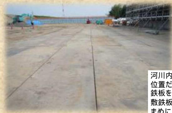
河川内工事であるため地盤が砂地で重機作業位置だけでなく、車両通行ルートにも全面に敷鉄板を設置している。(約2000枚) 工が進むと敷鉄板のズレや段差が発生する。当現場ではこまめに敷鉄板の敷き直しを行い、転倒・躓きを防止している。
