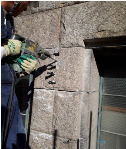
再生保存工事壁石割作業
