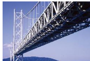
明石海峡大橋
