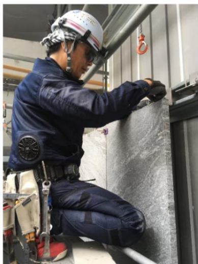
壁石取付作業
