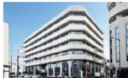
▲病院 外壁改修
