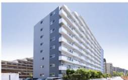
▲マンション 外壁改修
