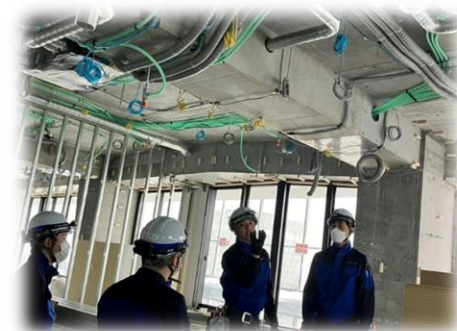
現場で施工確認チェック作業
