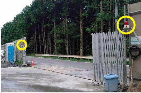
現場出入口のパトライト (警報音スピーカー付き)
