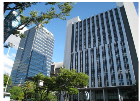
※堺地方合同庁舎全景
