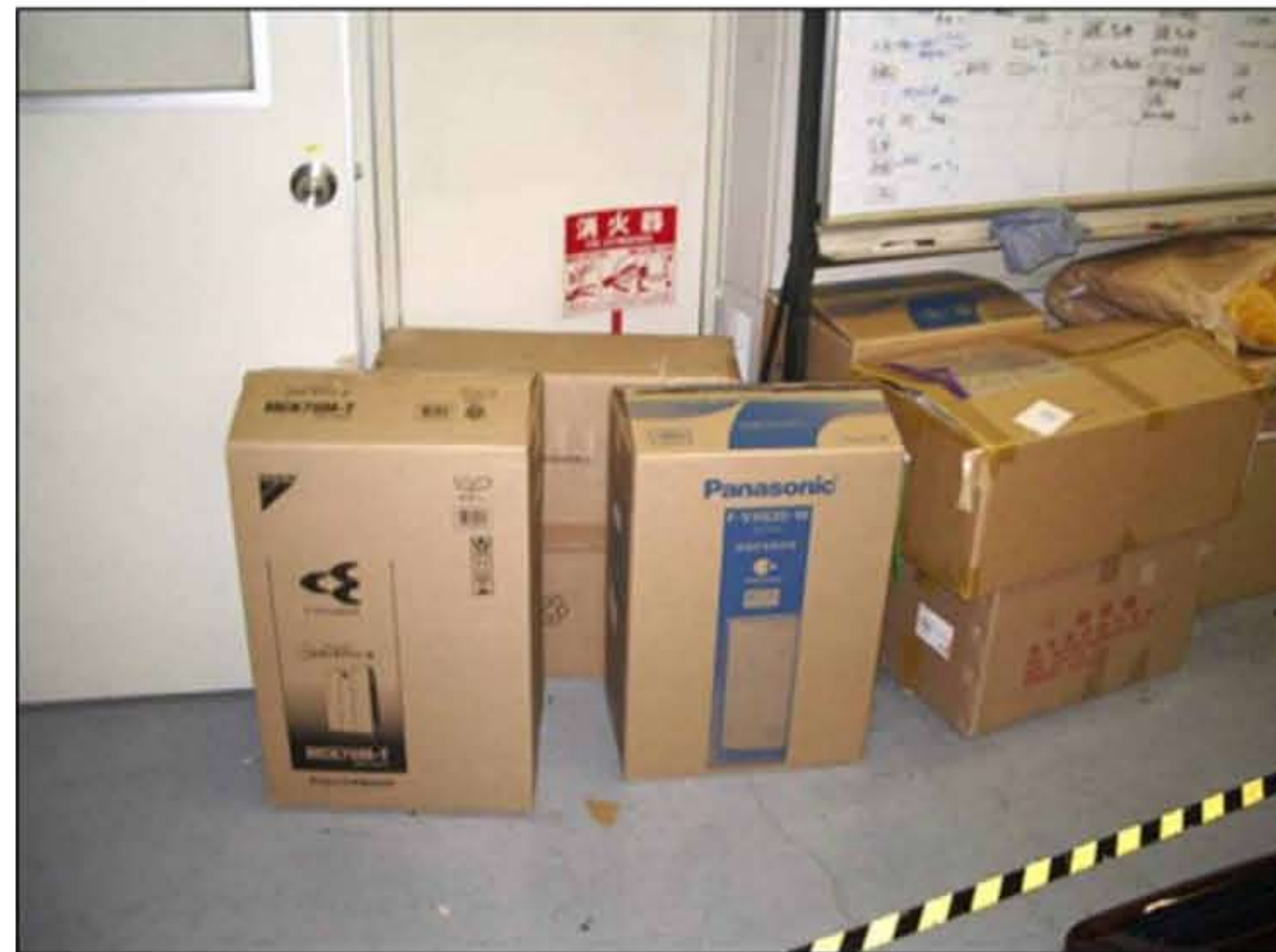
【例：消火器の前に荷物を置いている箇所】
