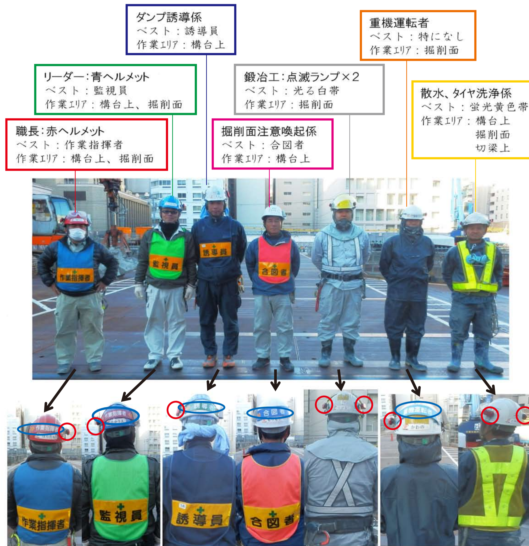
掘削面で作業を行う者は、ヘルメットに点滅ランプを装着 分担別にヘルバンドを取り付けた 現場内、様々な場所から分担を把握出来る様、見える化を実施した
