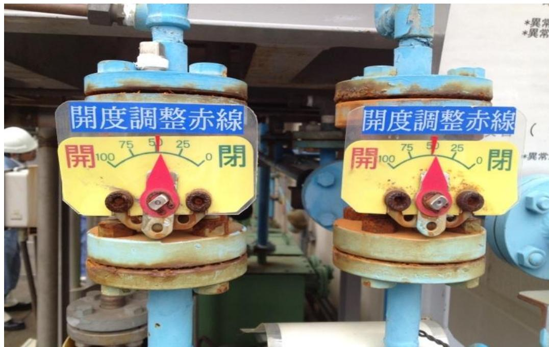
事例 22 化学設備に設置される送給バルブについて、送給量を間違えないようにするために、バルブの開閉装置に表示板を設けて、送給量を可視化している。
