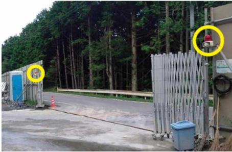
車両接近センサー検知システム
