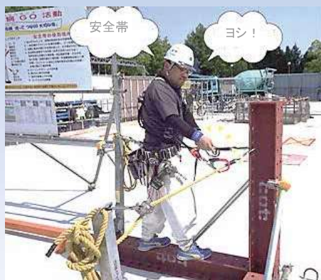
試行ゲートで点検と訓練
