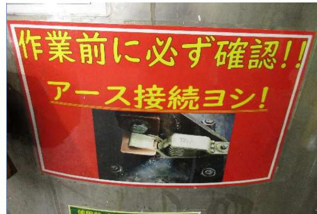
全ての移動タンクに対して、作業前の目に付く所にアース接続を促す表示を貼り付け、アース接続忘れないような取り組みを行っている。
