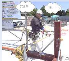
試行ゲートで点検と訓練
