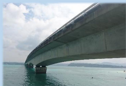
沖縄・古宇利大橋(全長1960m)に使用
