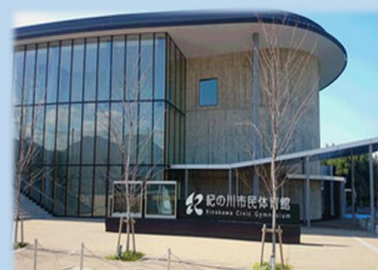
【施工例】紀ノ川市民体育館
