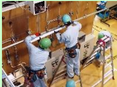
電気配線作業
