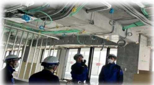
現場で施工確認チェック作業
