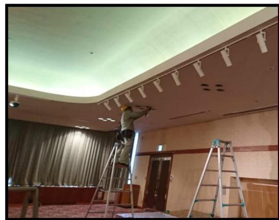
照明設備 改修
