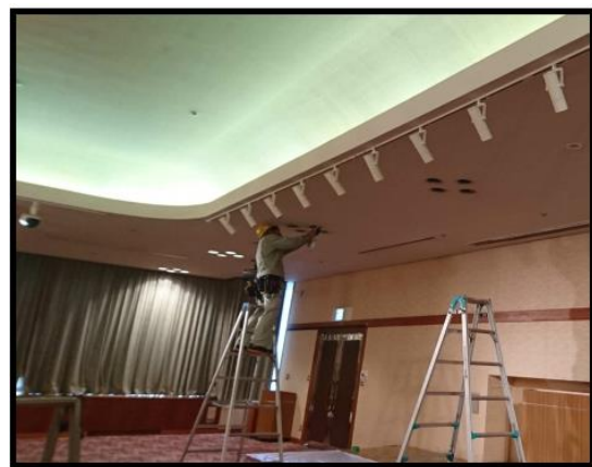
照明設備 改修
