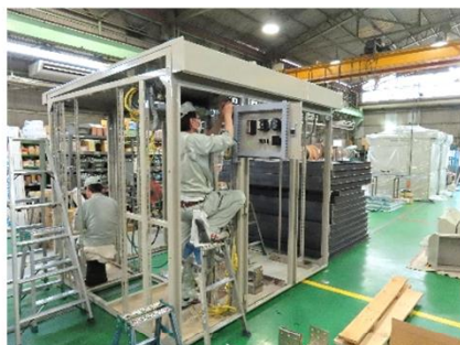
キュービクル組立作業
