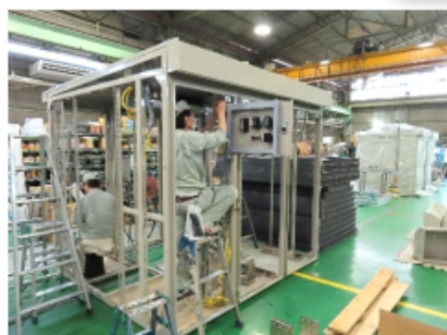
キュービクル組立作業
