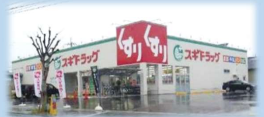
施工事例 スギ薬局 さま
